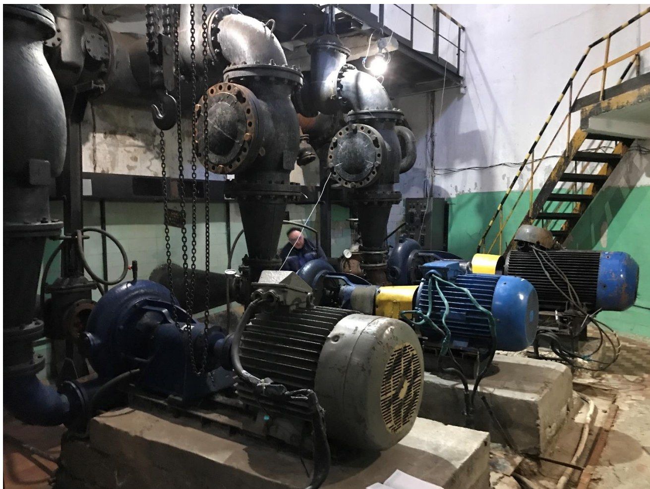
Рисунок 4.1. Внешний вид насосных агрегатов КНС №6
