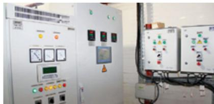
Проект по автоматизации насосных станций планируется реализовать на семи объектах Перми – двух канализационных и пяти водопроводных станциях. Новое оборудование уже установлено на КНС «Речник» и «Мозырьская». На станциях смонтирована запорная арматура, установлены дренажные насосы, источники бесперебойного питания, новые шкафы управления, расходомеры для учета объемов перекачки стоков, дробилки.
