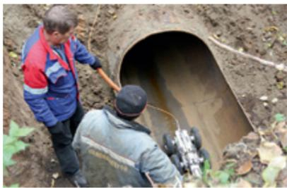
В службах теледиагностики для обследования канализационных коллекторов большого диаметра используются роботы на движущейся платформе. Инженеры-диагносты Перми ласково прозвали своего видеопомощника Роберт Старший. Поворотную видеокамеру, которой осматривают сети меньшего диаметра, 100–200 мм, называют Роберт Младший. Он может осмотреть трубу с разных ракурсов и определить, например, месторасположение закатанных колодезев, отводы и различные «сюрпризы» на сетях.
